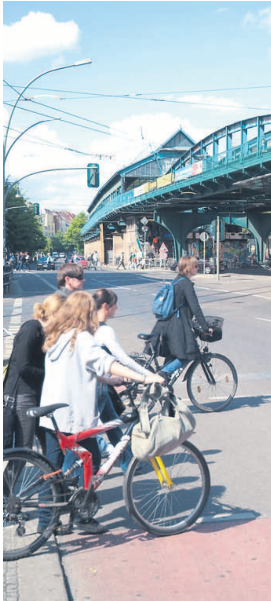
Sanierungsbedürftig. Am Himmelfahrtstag beginnen die Arbeiten an der U2. Auch der U-Bahnhof Eberswalder Straße wird erneuert. Foto: Kai-Uwe Heinrich
